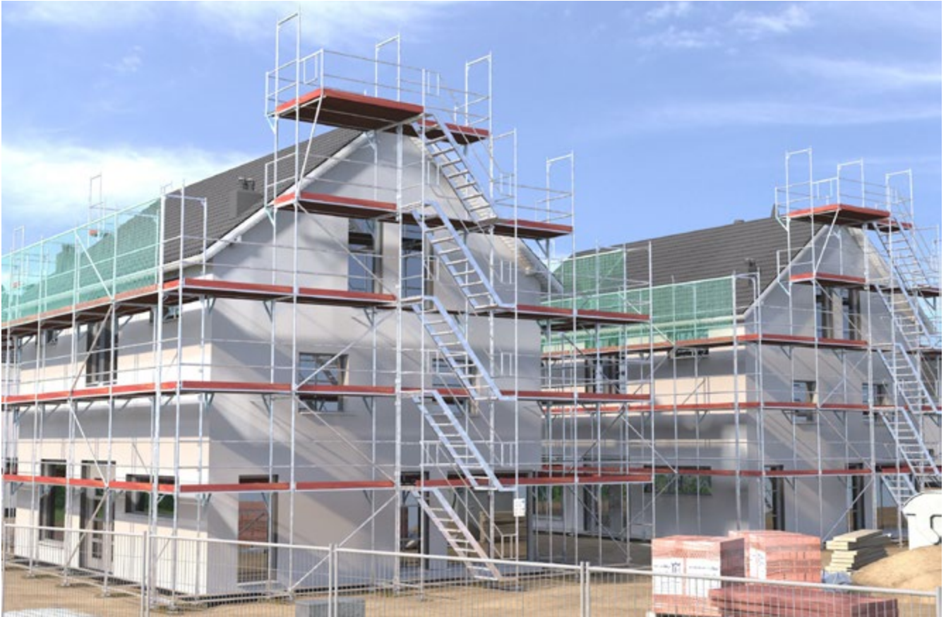
Abb. 53 fachgerechter Zugang zum Gerüst
