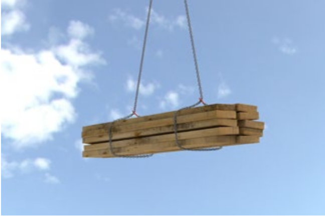
Abb. 79 Kettengehänge im Schnürgang
