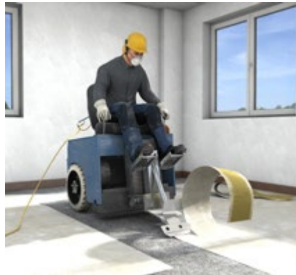
Abb. 90 Ausbau Fußbodenbelag
