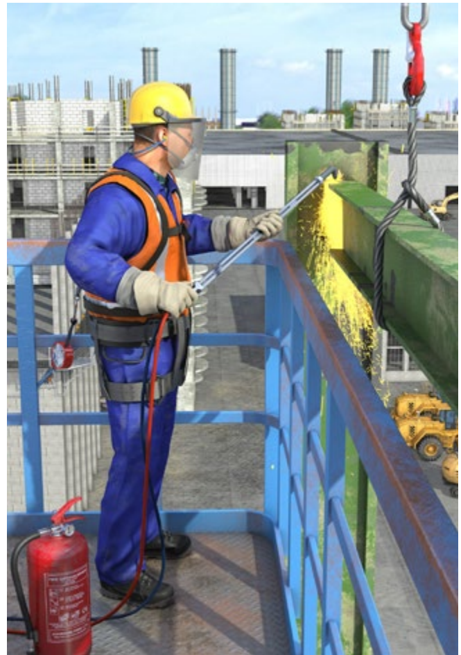
Abb. 25 Schneidbrennarbeiten
