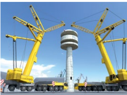
Abb. 108 Demontage eines Turms aus Stahlbeton
