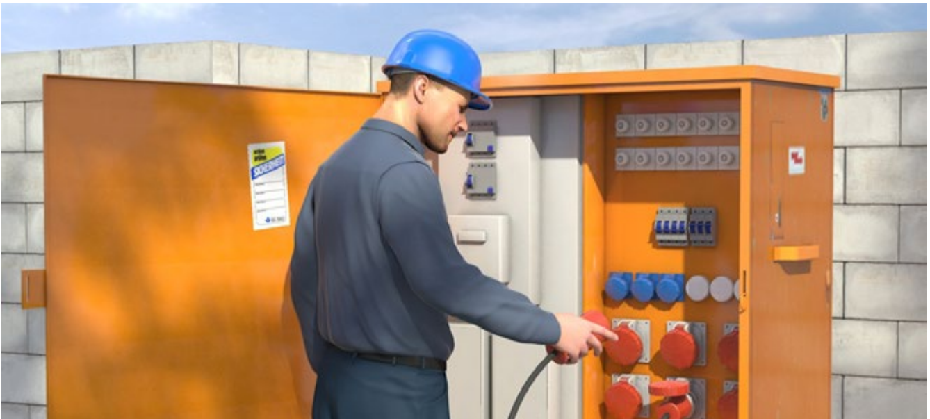
Abb. 20 Baustromverteiler zur sicheren Stromversorgung einer Baustelle
