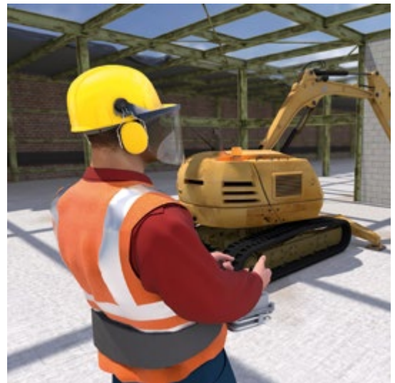
Abb. 95 Ferngesteuerte Abbruchmaschine
