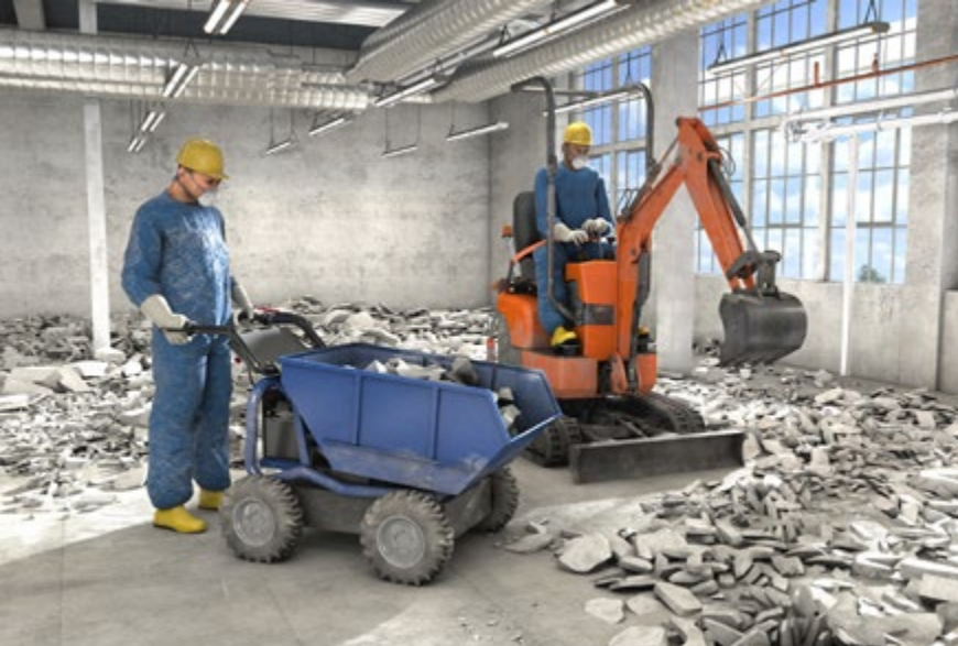
Abb. 92 Beräumung von Schutt
