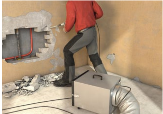
Abb. 12 Luftreiniger bei Stemmarbeiten
