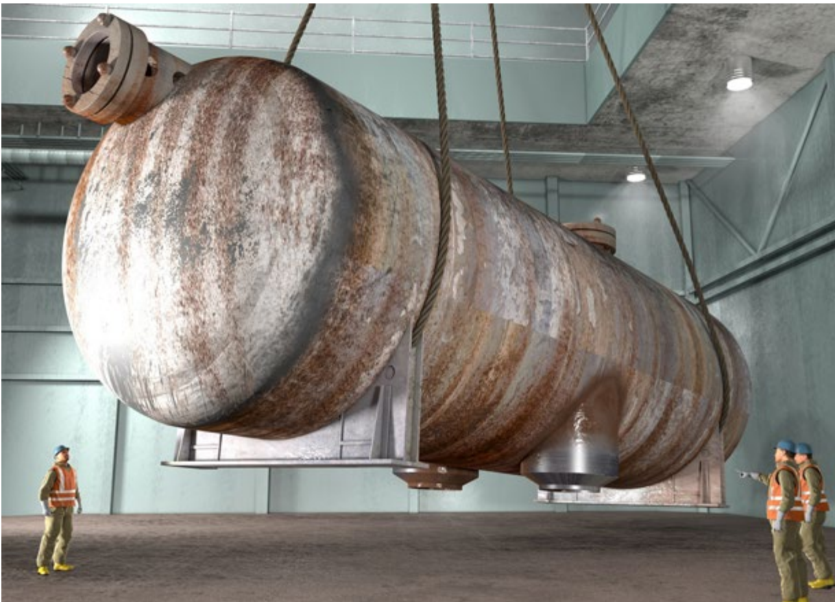
Abb. 113 Demontage Kessel
