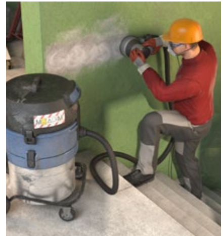
Abb. 10 Bau-Entstauber (z. B. Filterklasse M)
