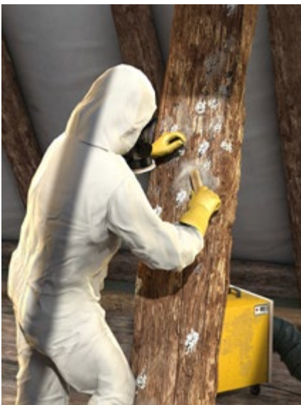
Abb. 13 Sanierung eines holzschutzmittelbelasteten Dachstuhl
