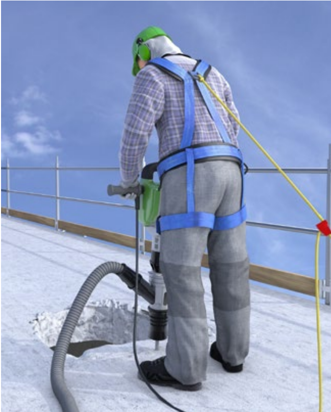
Abb. 101 Abbrucharbeiten mit PSAgA
