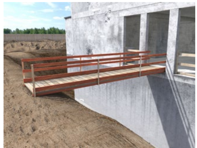
Abb. 6 Laufsteg mit Seitenschutz als Verkehrsweg
