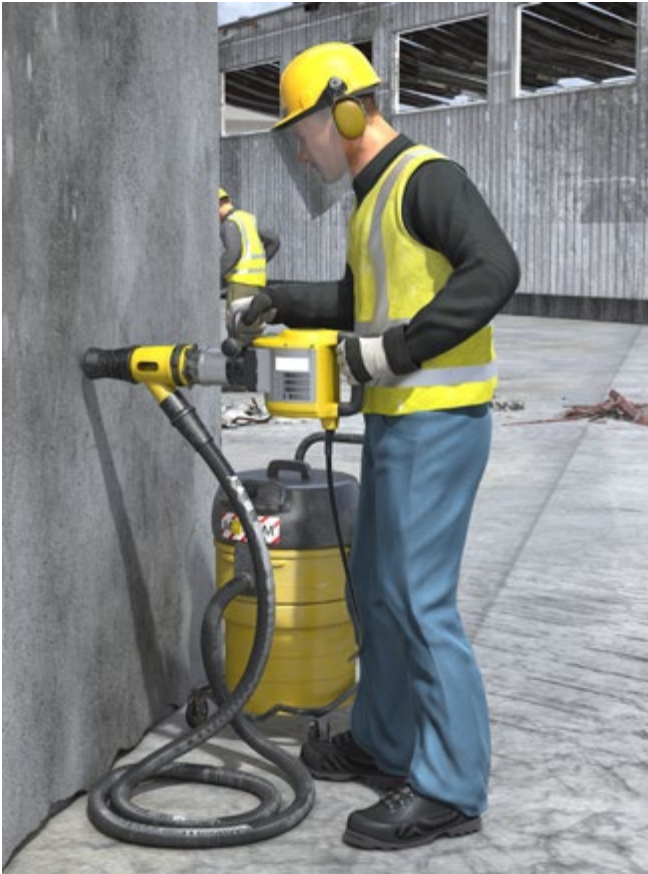
Abb. 85 Bohrhammer mit Absaugung
