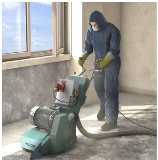
Abb. 16 Abschleifen PAK-haltiger Kleber
