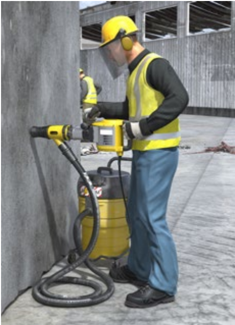
Abb 26 Persönliche Schutzausrüstung bei Arbeiten mit dem Bohrhammer
