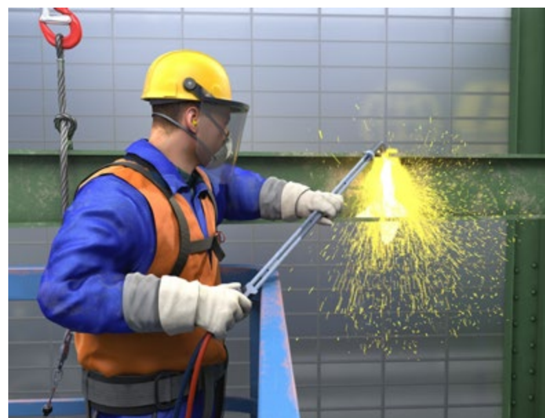
Abb. 56 Persönliche Schutzausrüstungen beim Brennschneiden
