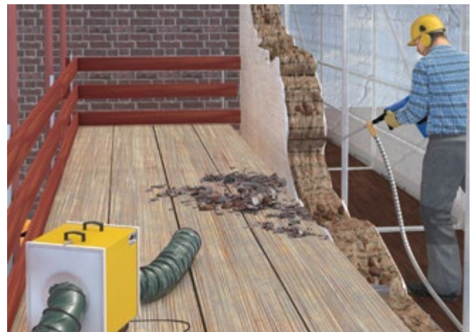
Abb. 4 Absturzsicherung durch Seitenschutz bzw. durch Fassadengerüst
