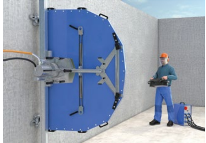
Abb. 105 Betonsägearbeiten
