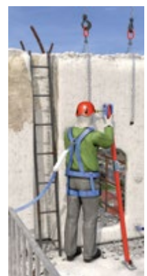
Abb. 110 Anschlagen eines Bauteils
