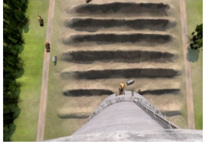
Abb. 119 Fallbett für eine Schornsteinsprengung
