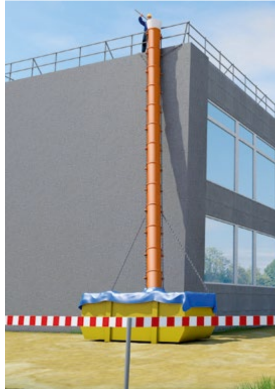
Abb. 103 Absturzsicherung an Schuttrutsche
