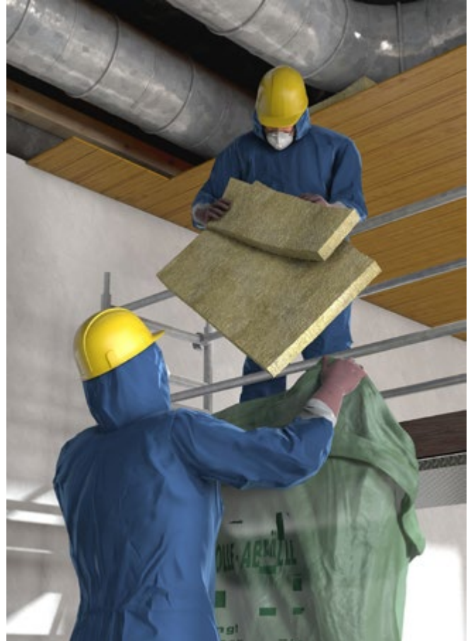
Abb. 11 Ausbau von Dämmplatten
