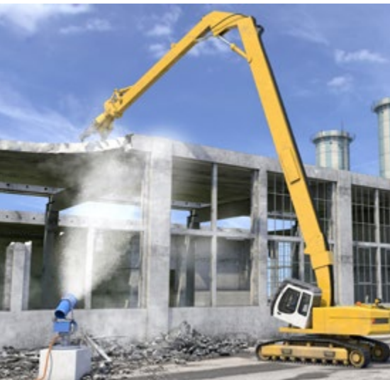
Abb. 93 Abbruchbagger mit Longfrontausrüstung
