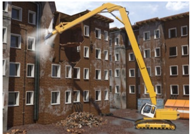
Abb. 84 Abbruchbagger mit Longfrontausrüstung
