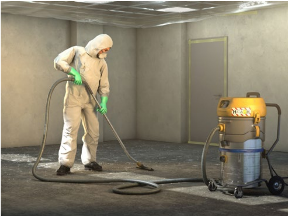
Abb. 19 Industriestaubsauger Staub- klasse H zur Reinigung einsetzen
