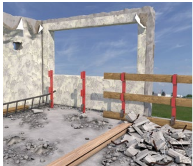
Abb. 111 Absturzsicherung vor der Demontage anbringen
