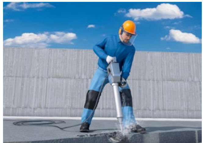
Abb. 39 Abbrucharbeiten mit geeigneter PSA
