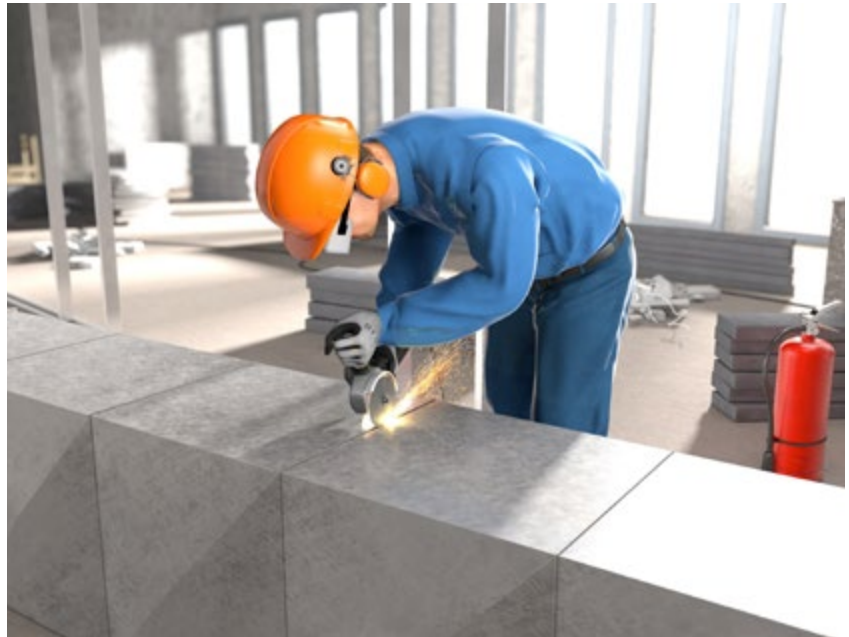
Abb 27 Persönliche Schutzausrüstung beim Trennschleifen von Metall
