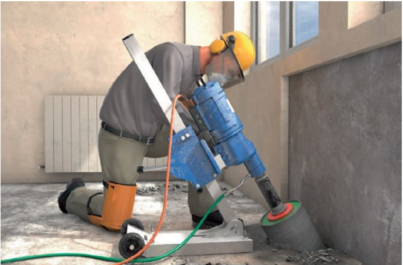
Abb. 40 PSA bei Betonbohrarbeiten
