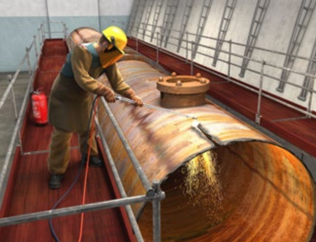
Abb. 114 Rückbau Rohranlage
