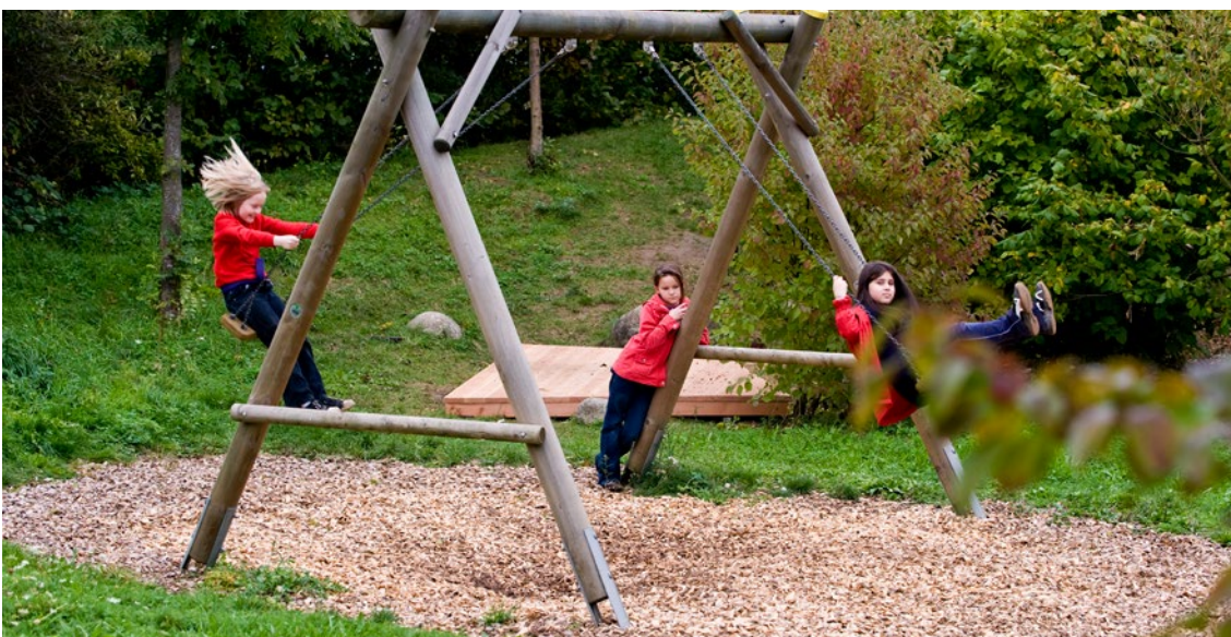
Abb. 13 Gesicherter Fallraum: Stoßdämpfende Materialien mildern den Sturz eines Kindes.
